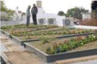
Cubierta viva sobre techo de chapas Municipalidad de Alta Gracia. Colectivo TABI-UNC Estudio Van-Gross.
