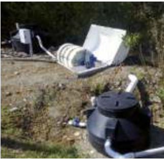
Biodiscos parcialmente enterrados.
