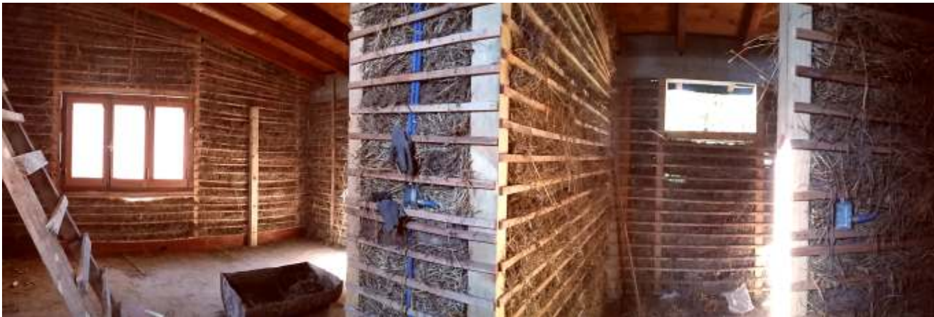
Quincha de madera y fibras. Quinua Arquitectura.
