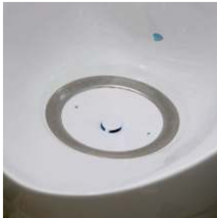
Mingitorio Seco, sin vertido de agua.
