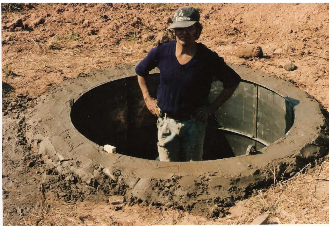
Figura 4.: Primera etapa de cementación, hormigón vaciado desde 0,9 m de profundidad hasta 10 cm sobre la superficie.
