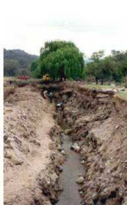
Figura 8.: Excavación de una zanja para la instalación de filtros y prefiltro en Agua de Oro, Córdoba (Baudino, 1998).
