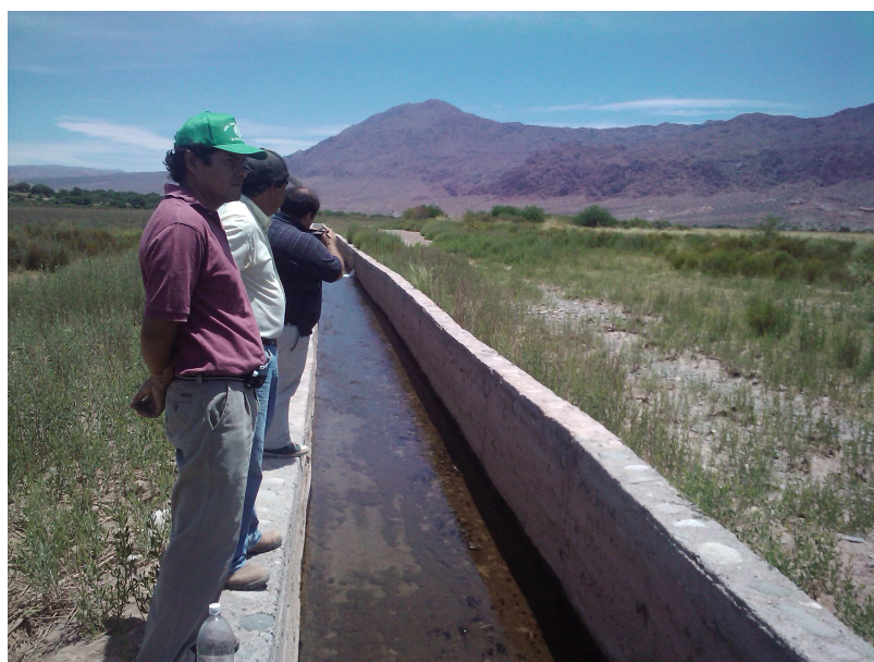
Figura 3.: Fotografía del canal principal revestido, con ingreso de agua desde las vertientes
