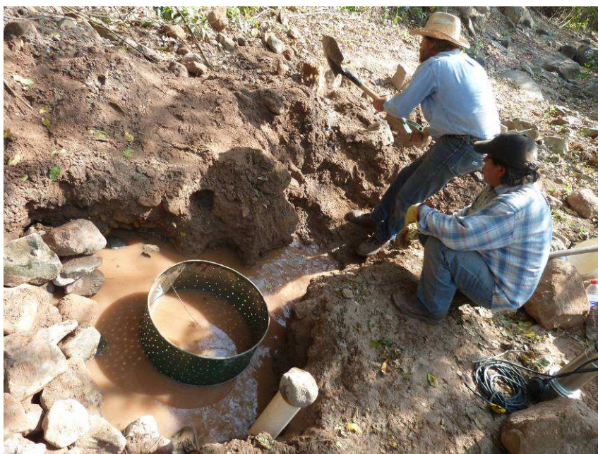
Figura 10.: Construcción del pozo de bombeo con sus respectivos piezómetros P1 y P2.
