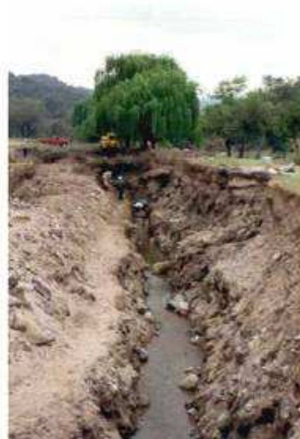
Figura 13.: Excavación de una zanja para la instalación de filtros y prefiltro en Agua de Oro, Córdoba (Baudino, 1.998).
