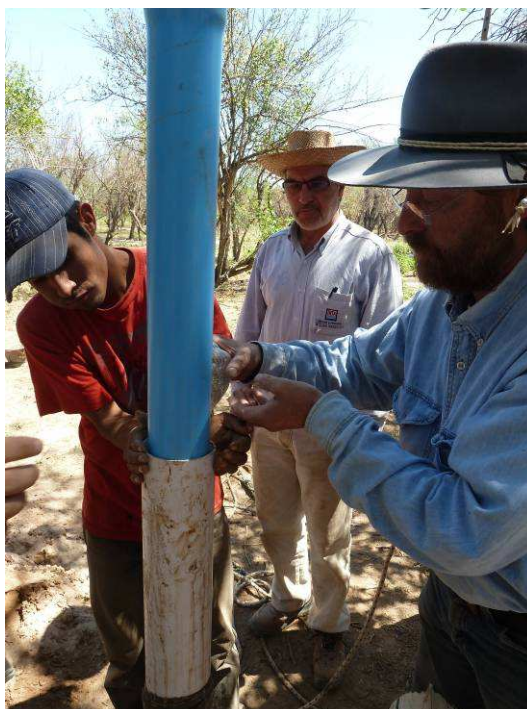
Figura 12.: Llenado del espacio anular con grava de 1 a 3 mm para constituir el prefiltro.
