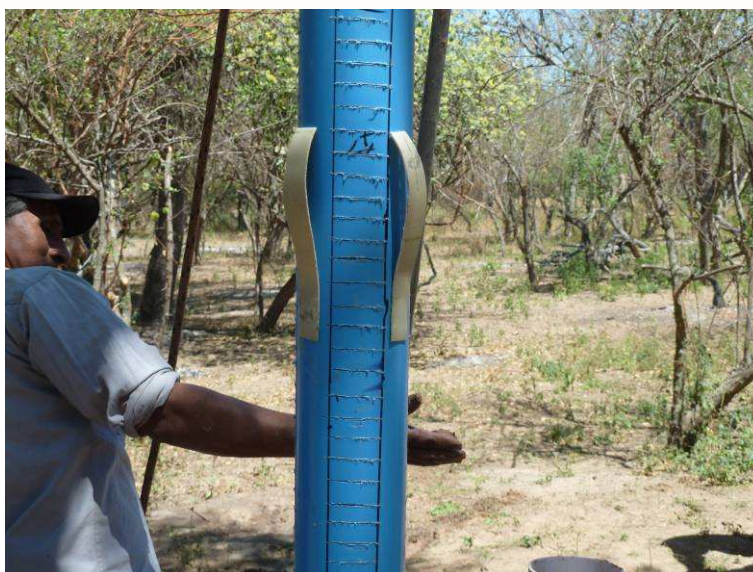
Figura 9.: Caño interno ranurado (filtros) con los flejes centralizadores.
