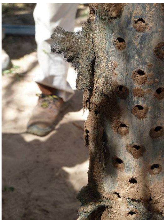
Figura 2.: La figura muestra el deterioro de la malla y la arena evidenciando el paso al pozo.
