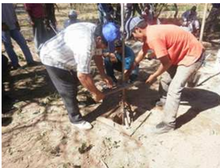
Figura 5.: Perforación del pozo con pala barreno.
