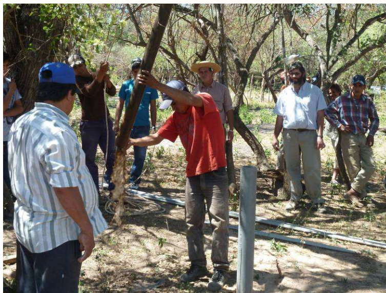
Figura 8.: Entubado externo del pozo y desbarrado.
