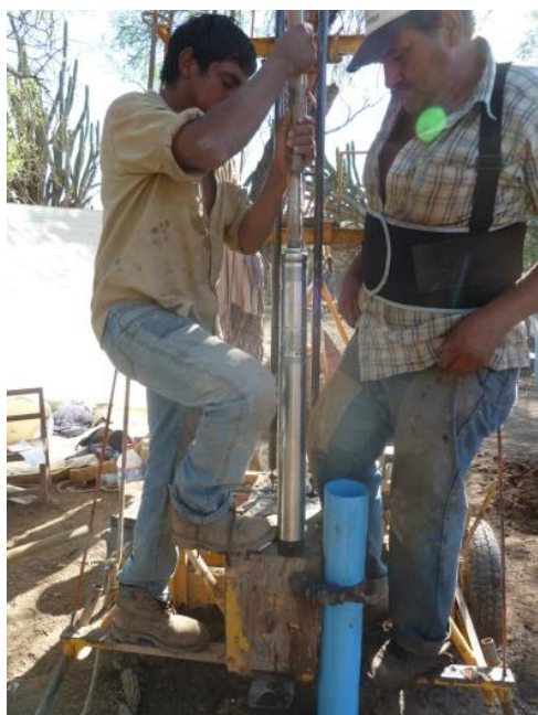
Instalación de la electrobomba sumergible
