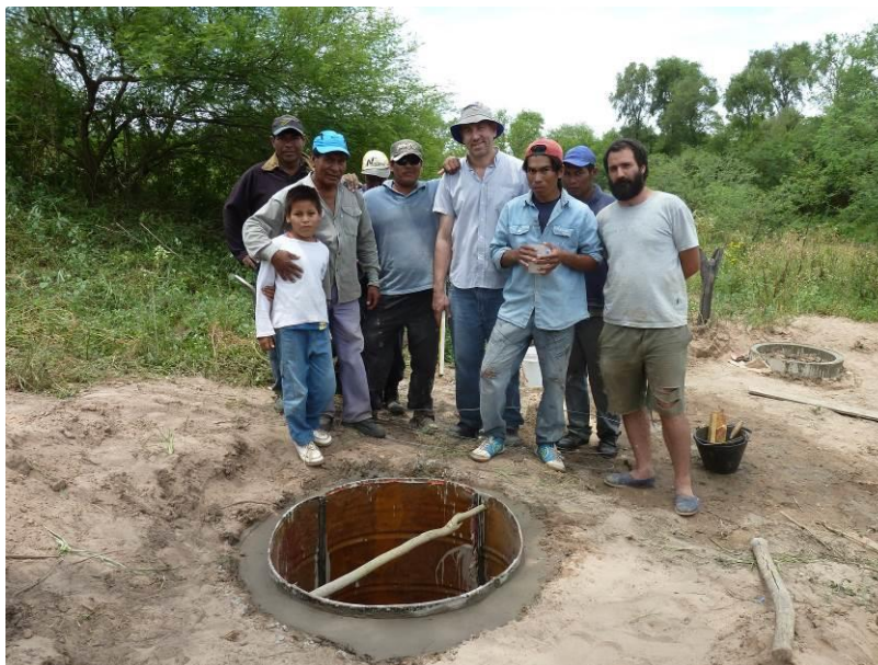
Figura 6.: Cavado y encofrado del primer metro. Pozo excavado y calzado.
