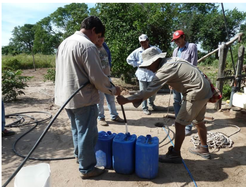
Figura 3.: Vaciado del pozo para facilitar el avance de la pala barreno.
