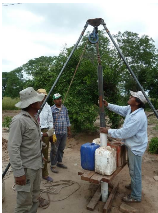
Figura 5.: Pozo entubado e inicio de los trabajo de sondeo. En la figura se observa la grampa con bidones con agua para dar peso y poder profundizar la columna de caños.
