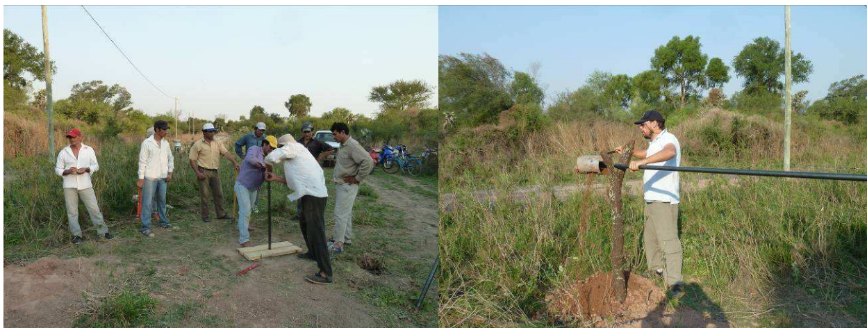
Figura 3.: Inicio capacitación de pozo con pala barreno con los integrantes de la organización del lugar. Se observa el técnico de INTA Córdoba, vaciando el material de la pala barreno extraído del pozo.
