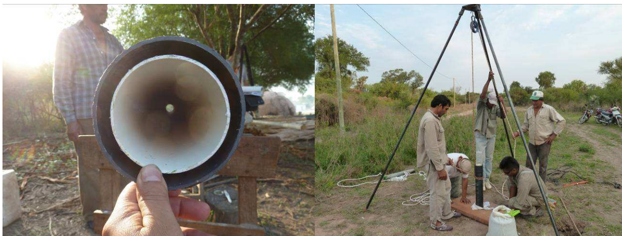
Figura 4.: Capacitación y taller en filtro doble modelo INTI. Instalación del filtro en el pozo, al estar suspendido en el pozo se asegura con una soga y un cepo en la boca del pozo.
