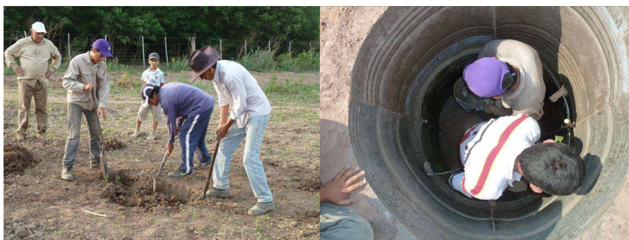
Figura 2.: Inicio capacitación de pozo excavado y calzado. Se observa el inicio de las tareas y posteriormente el encofrado y llenado con hormigón del segundo metro.
