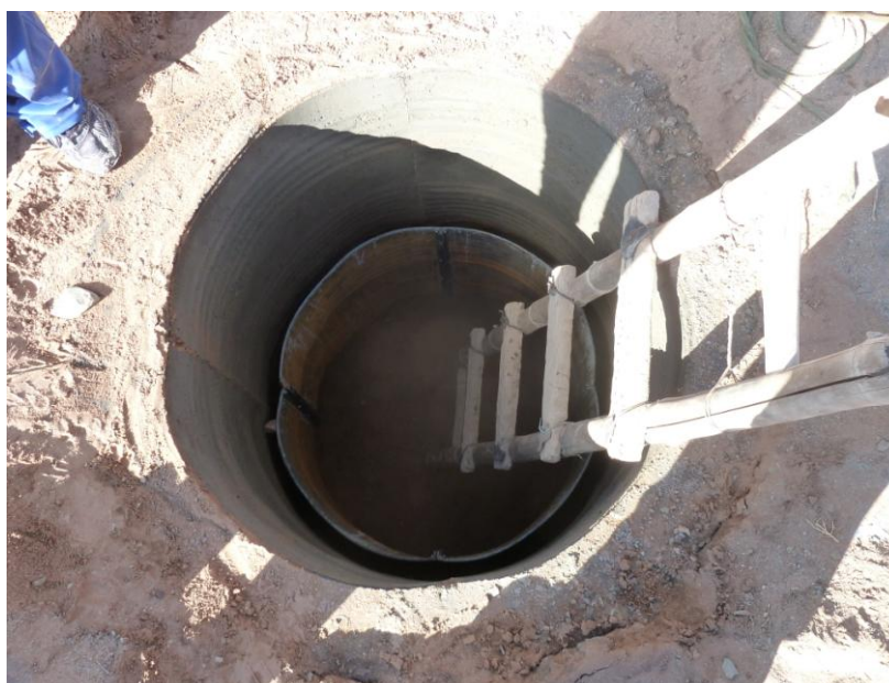
Figura 5: Colocación del moldes en el segundo metro.
