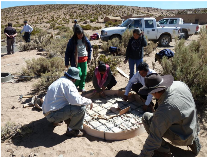
Figura 8: Construcción de tapa para el pozo.
