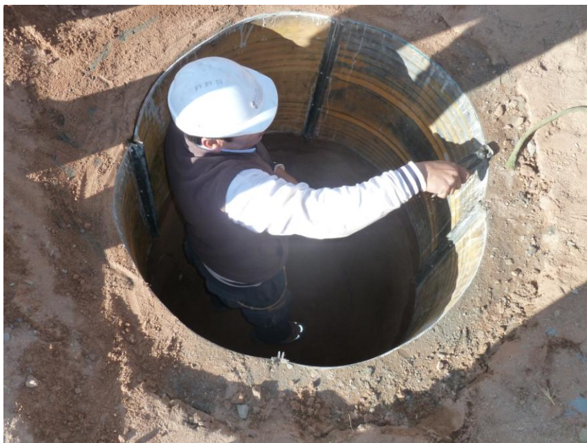
Figura 4: Excavación del 2 metro y retiro de molde del primer metro.
