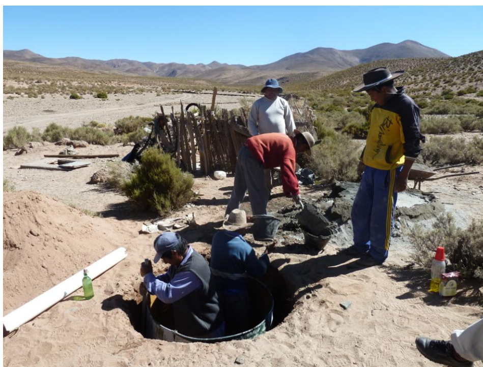
Figura 3: Vaciado e hormigón entre las paredes del pozo y el molde.
