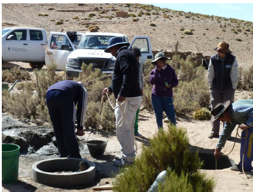
Figura 7: Anillos premoldeados.
