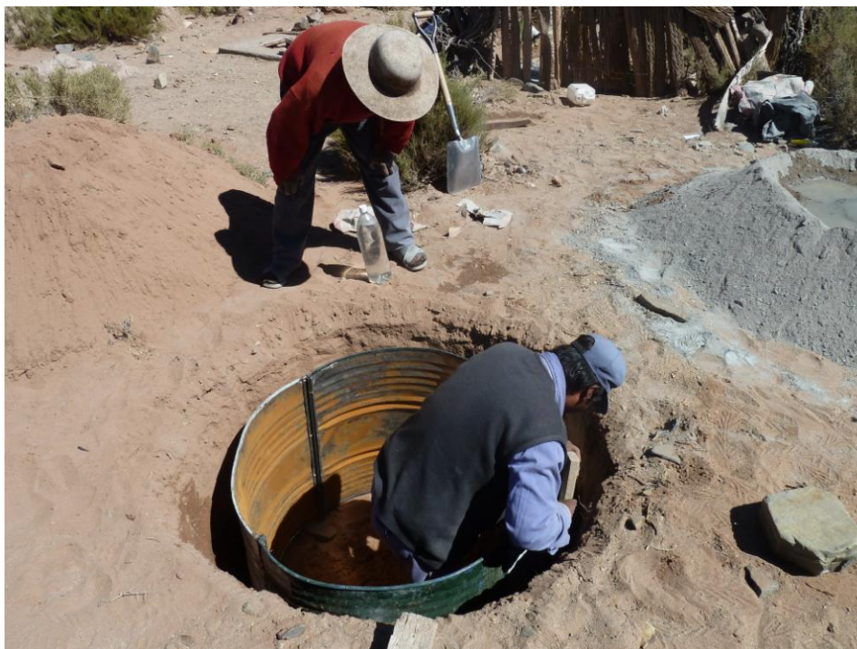
Figura 2: Colocación de molde de encofrado.
