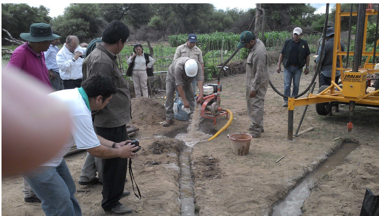
Figura 3.: Preparación del lodo de inyección.
