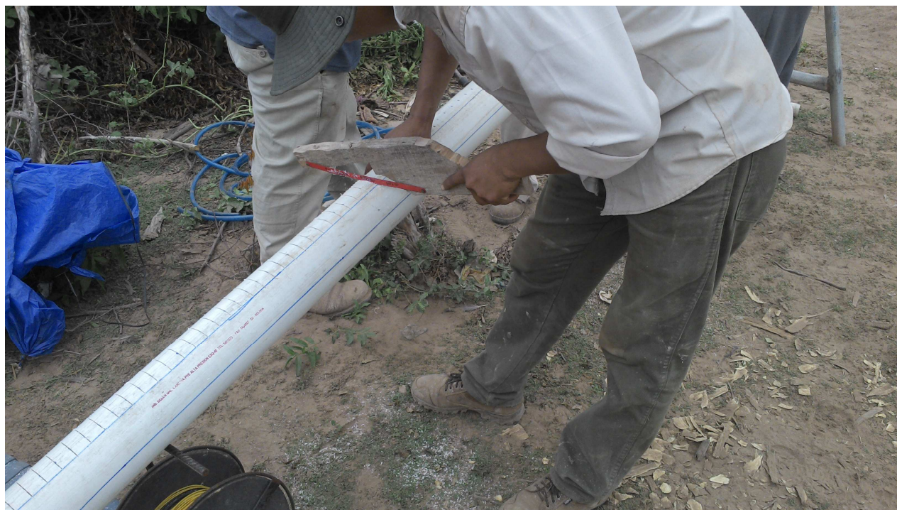
Figura 6.: Ranurado de las cañerías para filtro.
