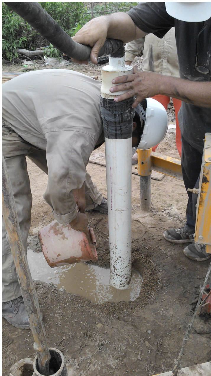
Figura 7.: Introducción del prefiltro de grava en el espacio anular y cabeza de inyección.
