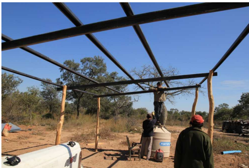
Figura 3: colocación de las alfajías
