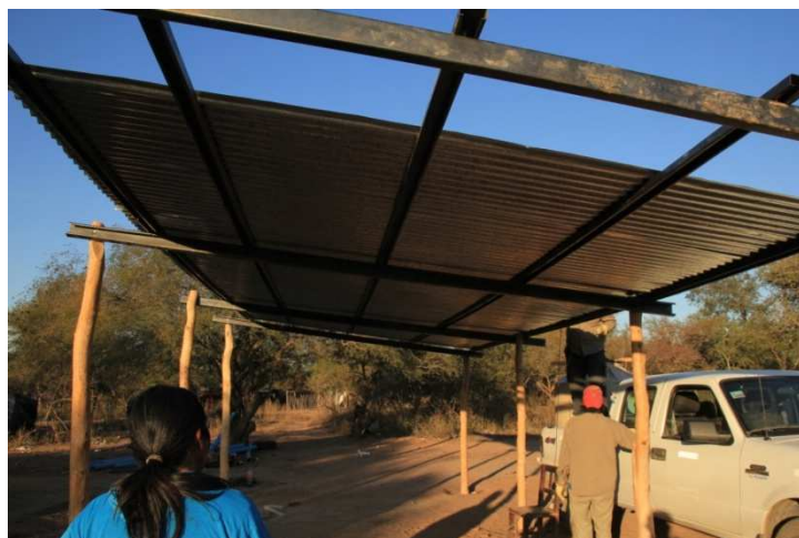
Figura 4: colocación de las chapas y canaletas.
