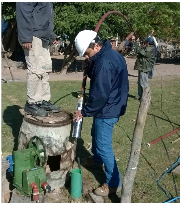
Figura 3: Colocación de bomba (Flia. Fernández)
