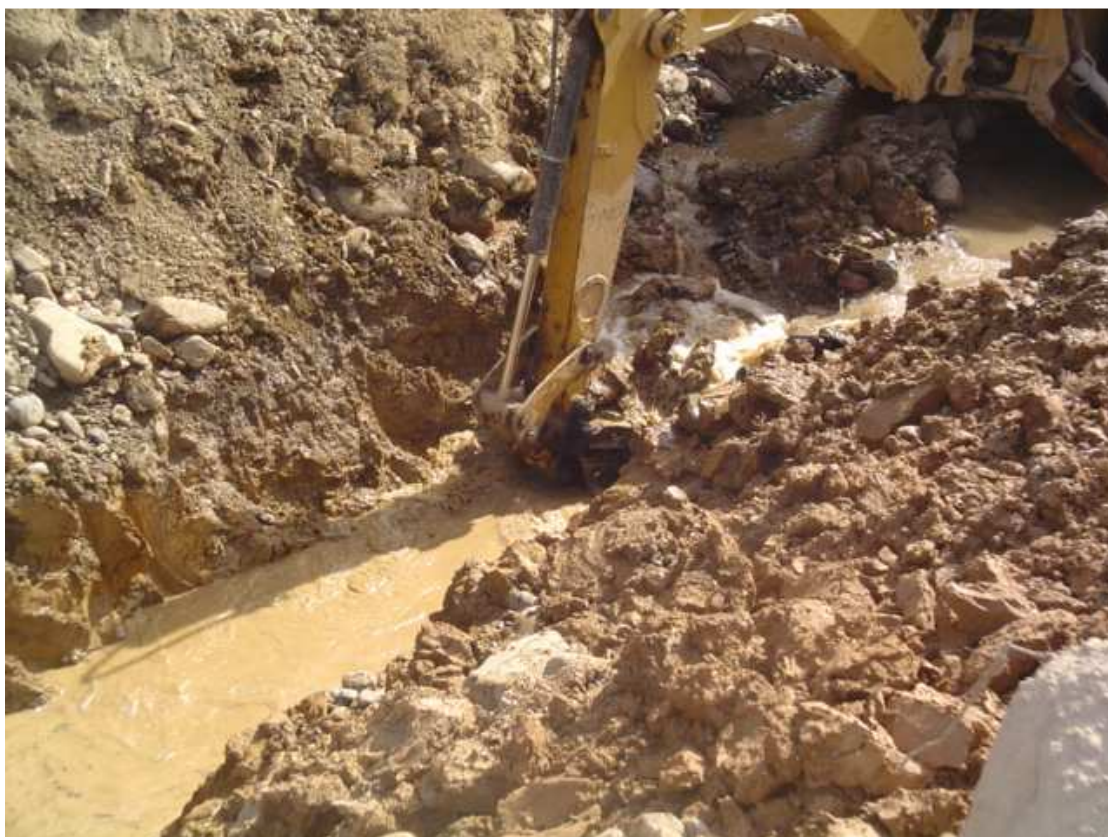
Figura 6: Excavación de una zanja para la instalación de filtros y prefiltro en Aguada Las Calas, Vaqueros, Salta. (Baudino, G; Mery, H., 2013)
