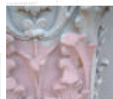
Pilastras: decapante e hidrolavado con agua caliente a 90°C
