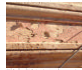
Friso: hidrolavado a alta presión (210 bar) con proyección puntual ("rotojet").
