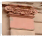
Pilastras y capitel: decapante y vapor a presión 105°C
