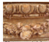
Pilastra y capitel: 2 manos decapante e hidrolavado con agua caliente a 90°C
