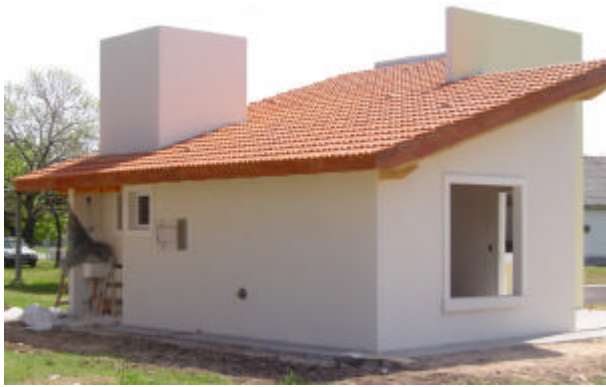
Fig. 2 . Prototipo de VIVIENDA INTI construido con bloques de concreto celular y cubierta tradicional con aislación térmica de lana mineral. Tiene baja transmitancia térmica en muros y techos: K=0,69 \text{ W/m}^2\text{K} y 0,58 \text{ W/m}^2\text{K} respectivamente. No posee riesgos de condensación superficial ni intersticial y un beneficio del 37%, en ahorro de energía, respecto a la referencia normativa
