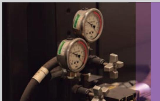
Ilustración 59- Manómetros con control visual – Rango no deseado (SAI)
