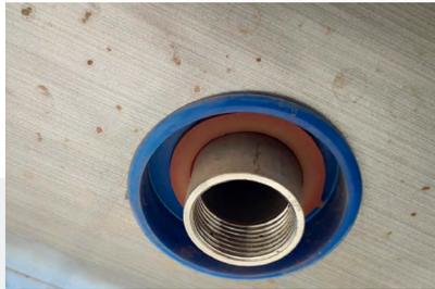
En caso de instalar un equipo nuevo, se aconseja elegir un modelo que tenga una entrada auxiliar para insertar el ánodo. Esta entrada, tipo hembra de  $\frac{3}{4}$ " , debería ser del mismo acero inoxidable del tanque o de bronce.
