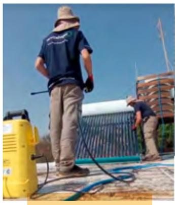
Cuando los equipos EST requieran de una limpieza interior por acumulación de sarro y/o incrustaciones, se recomienda utilizar un método de limpieza mecánico, por ejemplo, agua a presión con una hidrolavadora. Otra alternativa es el empleo de un método químico, mediante la aplicación de vinagre blanco diluido con agua al 10-20%, siempre que se realice un enjuague final. Es necesario prestar especial atención a la resistencia eléctrica que es el lugar de mayor deposición de sarro (incrustación).
