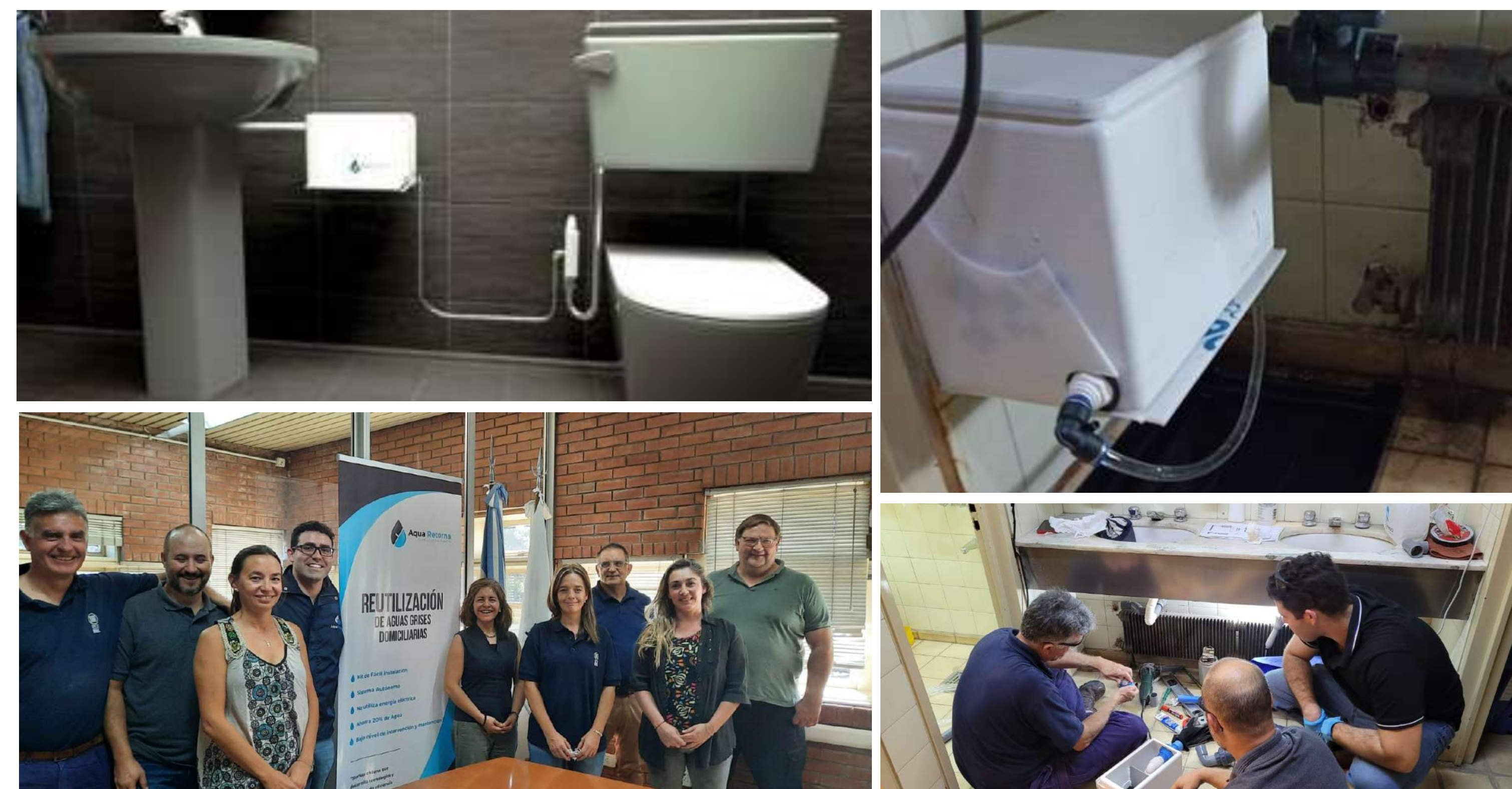
Render del equipo / Prototipo instalado / Equipo de trabajo / Instalación del prototipo en la sede.
