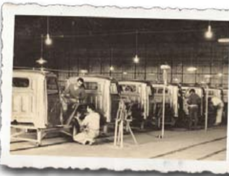
Línea de montaje de la cabina del Rastrojero Diesel (1954). Este vehículo utilitario fue durante toda su historia el de menor costo operativo del mercado argentino.
