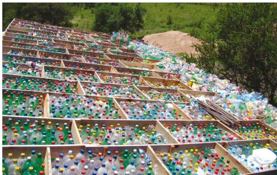
Aislación térmica del techo a partir de fardos de botellas PET; se aprovecharon unas 15.000 unidades.
