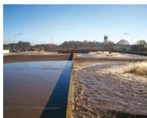
Reactor aeróbico de una planta de tratamiento cloacal.
