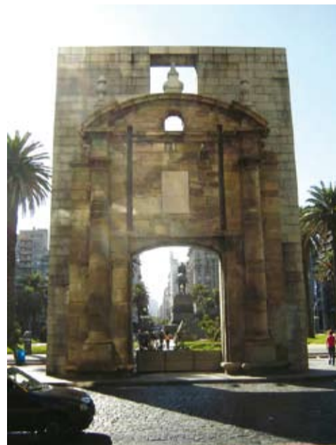
La Puerta de la Ciudadela de Montevideo, restaurada con la asistencia técnica del INTI.
