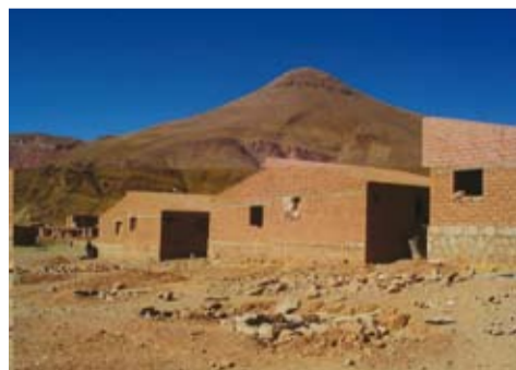
El barrio de Susques en Jujuy, un ejemplo de construcción con tierra.
