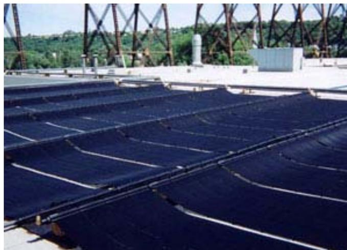
Figura 5: Foto de un colector de placa plana sin cubierta
