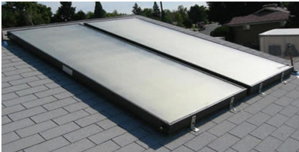
Figura 2: Foto de un colector solar de placa plana con cubierta
