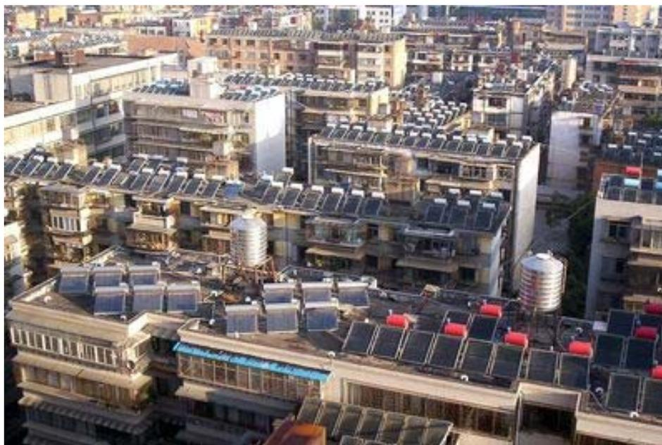
Figura 19: Calentamiento solar de agua en China
