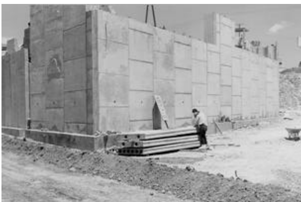
Figura 4.13 Estribo en un puente hecho con elementos prefabricados
