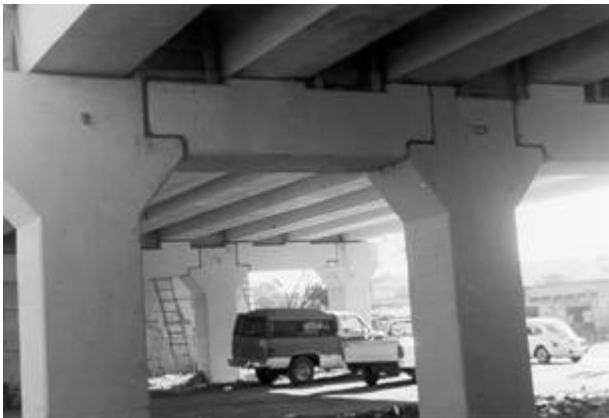
Figura 4.14 Subestructura de un puente totalmente prefabricado. En las fotos se muestran las columnas, travesas portantes y vigas cajón
