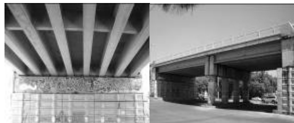
(b) Puente No.2
