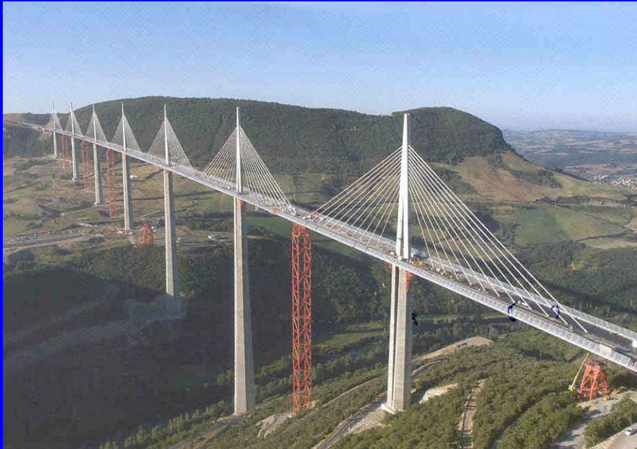
Viaduc de Millau
