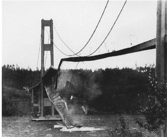
*Figura C3.8.3.2.2 – Fenómeno de flameo en el Puente de Tacoma Narrows*
