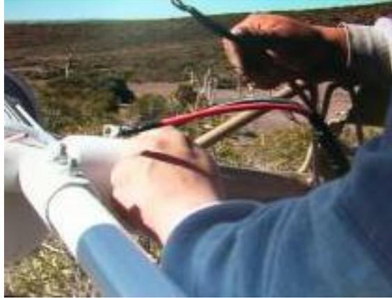
Este será conectado en la bornera que posee el aerogenerador en el eje vertical. El otro extremo de dicho cable será conectado al regulador de tensión en la bornera que este posee a tal efecto.
