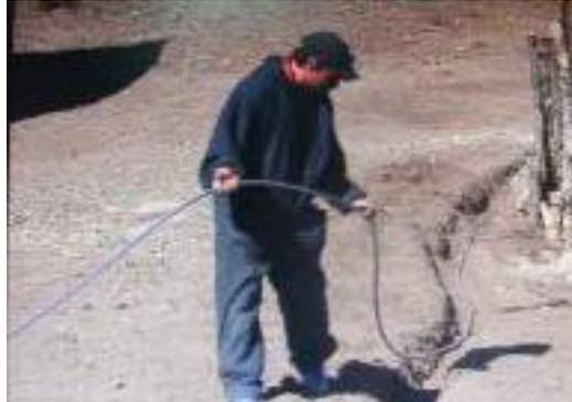
A continuación se procede a cavar la zanja por la cual pasará el conductor de bajada desde el aerogenerador hasta el gabinete contenedor de equipos.
